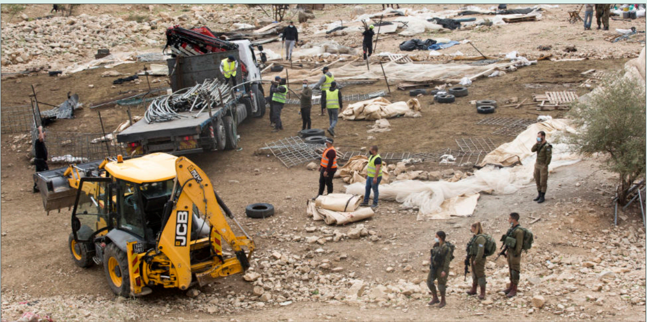
▲ Las fuerzas israelíes utilizan maquinaria de JCB para destruir tiendas y cobertizos para el ganado en la comunidad ganadera de Wadi Al-Ahmar, en la zona central del valle del Jordán, en enero de 2021. Créditos de la fotografía: Keren Manor/Activestills
